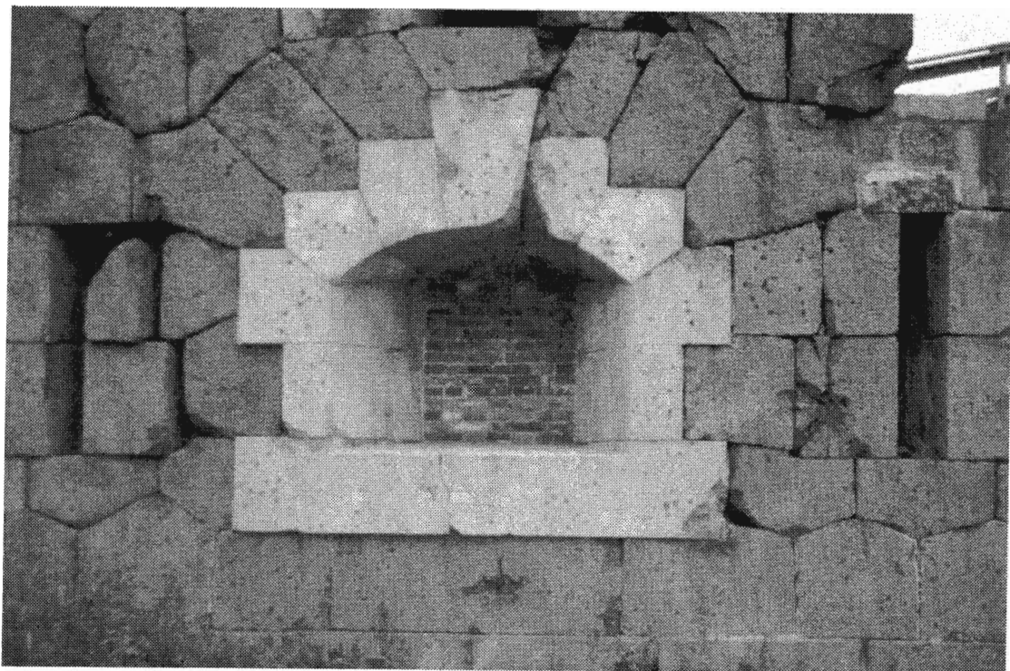
Kuva 2. Brännklintin tornin punagraniittista ulkoseinää. Kuva M. Kykyri.
