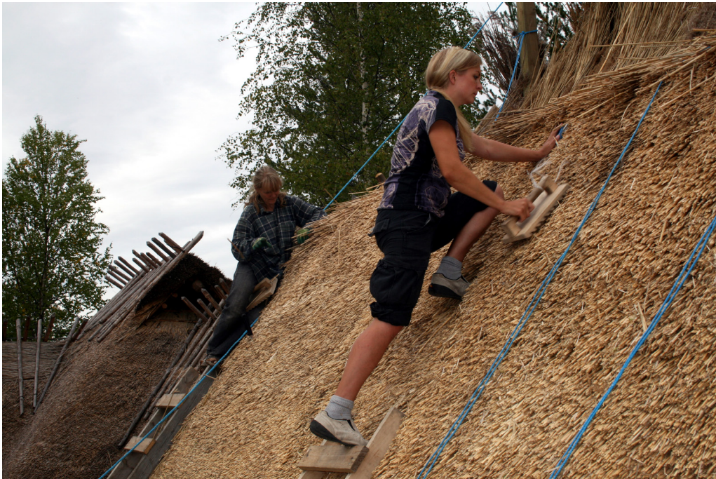
Kuva 5. Ruo'ot löytiin oikeaan asentoon porrastettua tamppilautaa käyttämällä. Taka-alalla työskentelemässä Hannele Huuromonen, etualalla Inga Nieminen. (Kuva: Sami Viljanmaa.)
