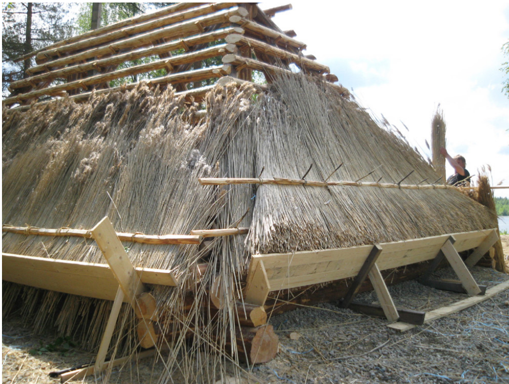
Kuva 4. Ensimmäinen ruokokerros ladottiin telineen päälle ja kiinnitettiin paikalleen puurimojen ja koivuvitsaksien avulla. Seuraavat kerrokset lyötiin samaan kulmaan katon lappeen kanssa. (Kuva: Inga Nieminen.)
