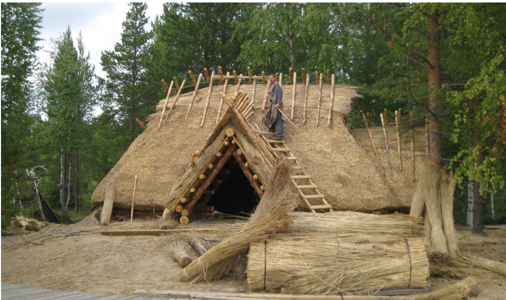
Kuva 7. Ensimmäinen ruokokattoinen konstruktio harjaa vaille valmiina. Tikkailla seisomassa Thomas Mann. (Kuva: Inga Nieminen.)
