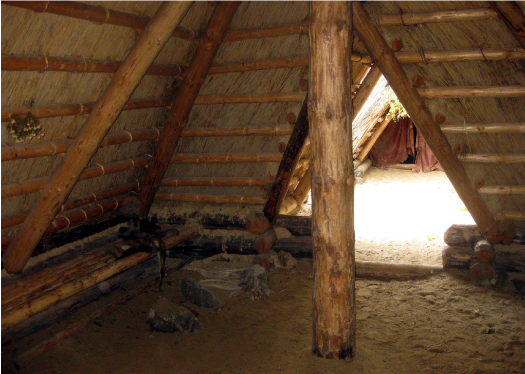
Kuva 6. Ruokojen vitsaskiinnitykset näkyvät talojen sisäpuolella ruodepuiden ympärillä. Ruokojen kukinnot on leikattu pois ja seinät käsitelty palonestoaineella. (Kuva: Sami Viljanmaa.)
