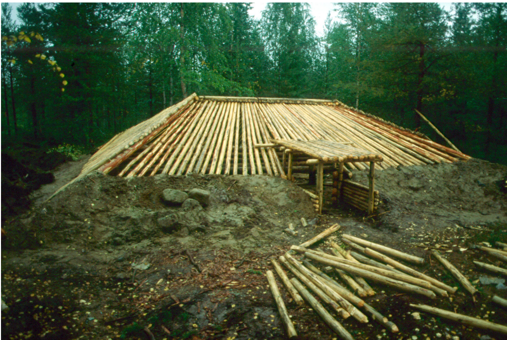
Kuva 1. Kivikauden kylän ensimmäisen asumuskonstruktion runko lähes valmiina. (Kierikki-keskuksen kuva-arkisto, kuvaaja tuntematon.)
