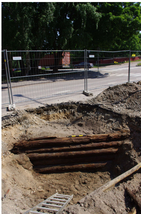
Kuva 3. Ruukinkadun alta paljastuneen hirsikehikon W-seinämää. (Kuva: M. Kykyri.)
