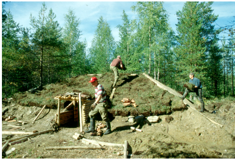
Kuva 2. Asumusrekonstruktion kattamista kesällä 1997. Etualalla astelee Aulis Forss, katolla työskentelee Patrik Franzén, oikealla turpeita tuomassa Sami Kesti. (Kierikkikeskuksen kuva-arkisto, kuvaaja tuntematon.)
