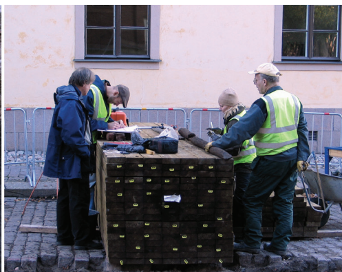
Kuva 4. Dendroarkeologisten näytteiden otossa on kiinnitettävä huomiota koko rakenteeseen sekä näytteen edustavuuteen ja laatuun. Kuvassa näytteiden ottoa ja kenttäanalyysiä Turun tuomiokirkon kupeessa Varhainen Turku -kaivausprojektissa vuonna 2005. (Kuva: P. Repo.)
