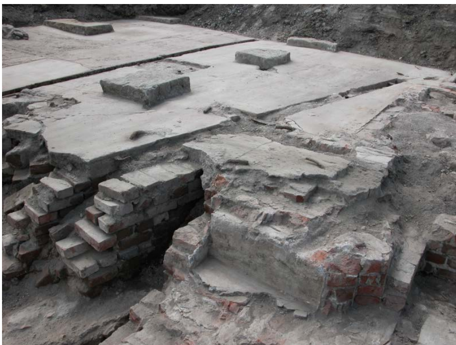
Kuva 2. Frenckellin massahiomon raunioita heinäkuussa 2010. Vuonna 1877 valmistuneeseen rakennukseen on ilmeisesti 1900-luvun alussa tehty betonilattia. Kuva: Sami Raninen, Pirkanmaan maakuntamuseo.
