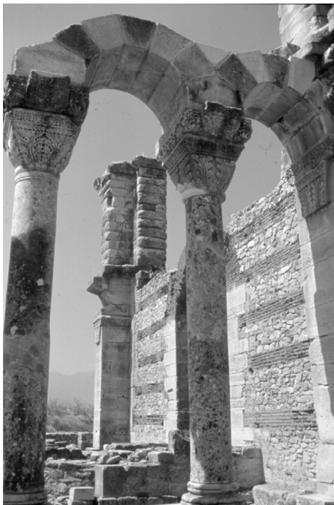
Kuva 3. Philippi, basilika B 500-luvulta. Vuorotellen vaihtelevia kivi- ja tiilirivejä seinärakenteissa. Kuva P. Hamari.
